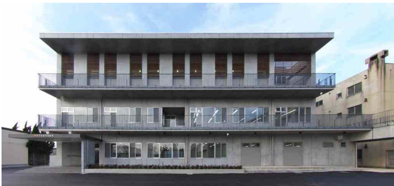
新潟県警察機動隊庁舎棟
